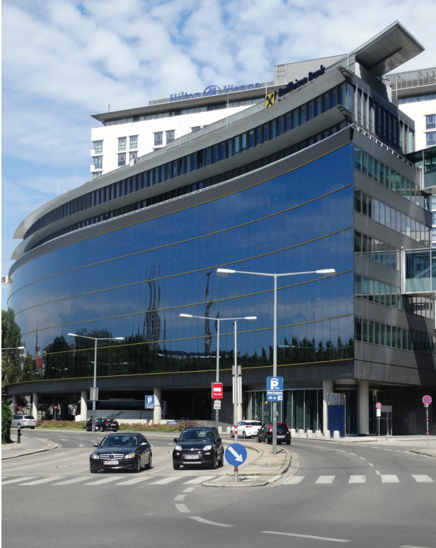
Il. 7. Hans Hollein, budynek biurowy Die Welle, Wiedeń, Austria, 2008 (fot. A. Serafin)
