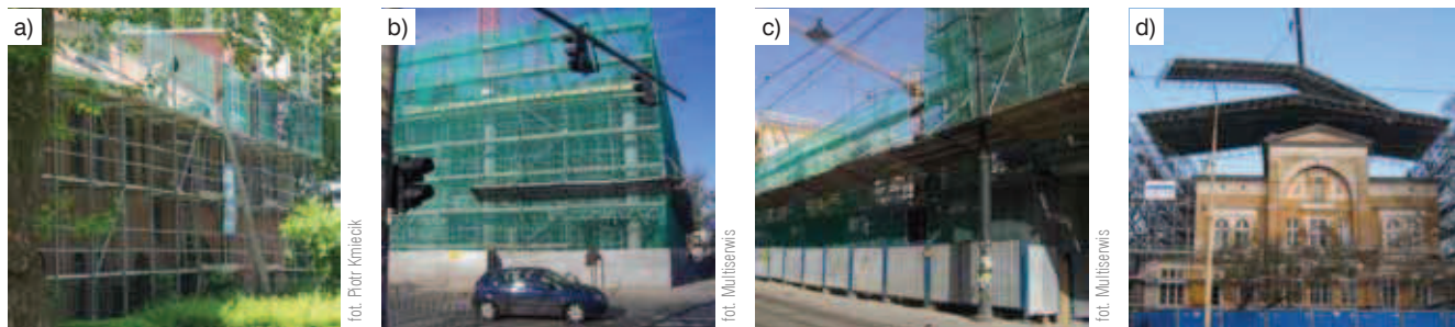
Rys. 1. Przykłady zastosowania rusztowań ochronnych (opis w tekście)
