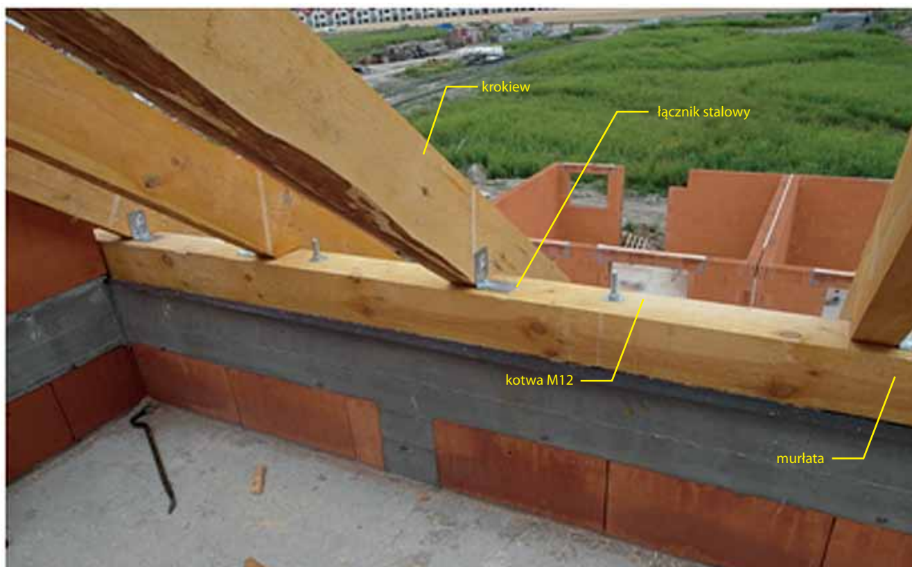
Rys. 4. Połączenie konstrukcji drewnianej dachu ze ścianami budynku
