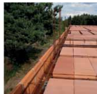
Rys. 3. Ściany parteru z kształtkami wieńcowymi
