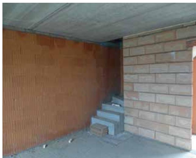
Rys. 5. Ściana działowa wykonana na zaprawie zwykłej
