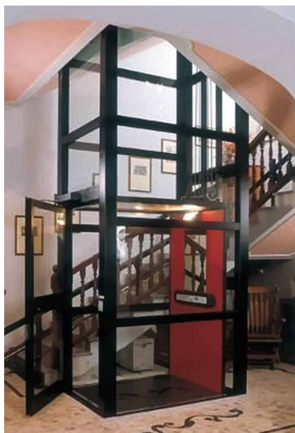
Fot. 2. Platforma do podnoszenia osób niepełnosprawnych
