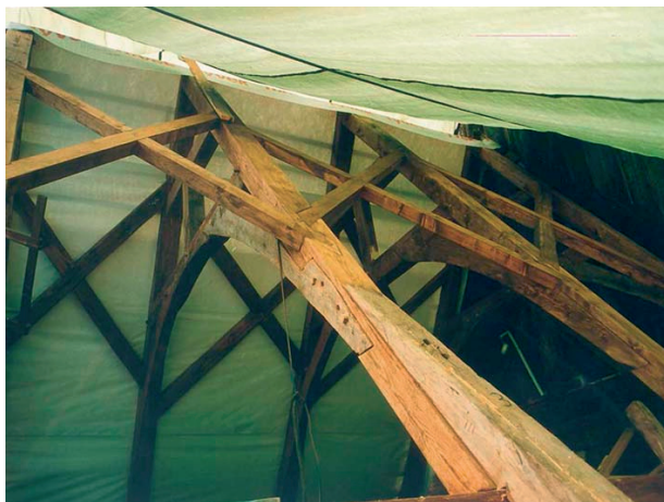
Fot. 14. Więźba dachowa prezbiterium po konserwacji w Tarnobrzegu Pałuckim.
