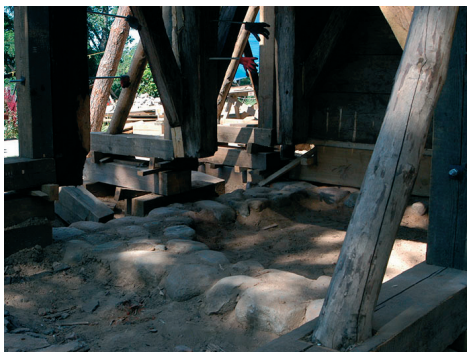
Fot. 7. Rekonstrukcja fundamentów wieży w Wylatowie
