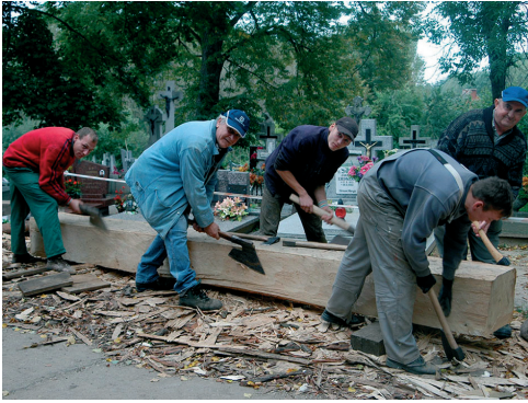
Fot. 10. Formowanie podwalin toporami w Wylatowie
