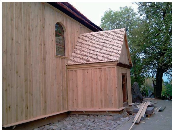
Fot. 15. Dębowy gont na kruchcie kościoła w Wylatowie.
