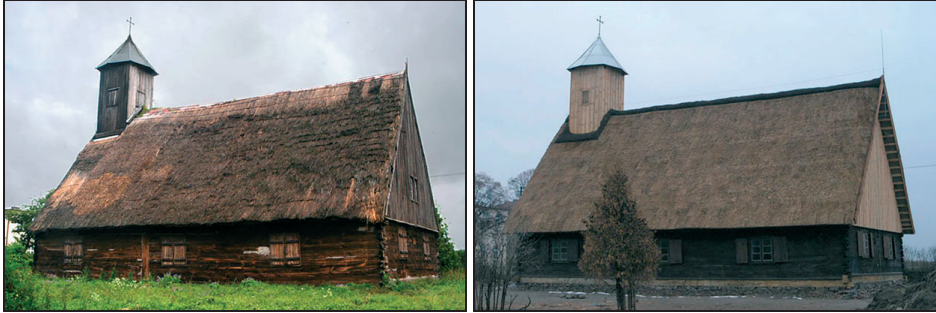
Fot. 2, 3. Kościół w Jarantowicach, stan przed i po konserwacji
