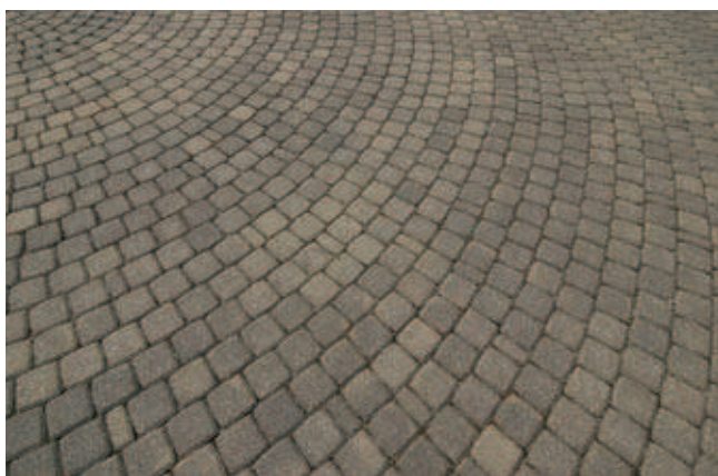
Rys. 4. Nawierzchnia brukowa z kostki wibrobetonowej [4]
