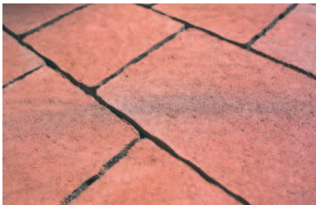
Rys. 3. Bruk z kostki z betonowej [3]
