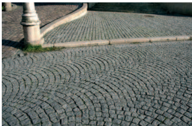
Rys. 1. Nawierzchnia brukowa z kostki granitowej w historycznym centrum Krakowa (fot. Piotr Skucha) [1]
