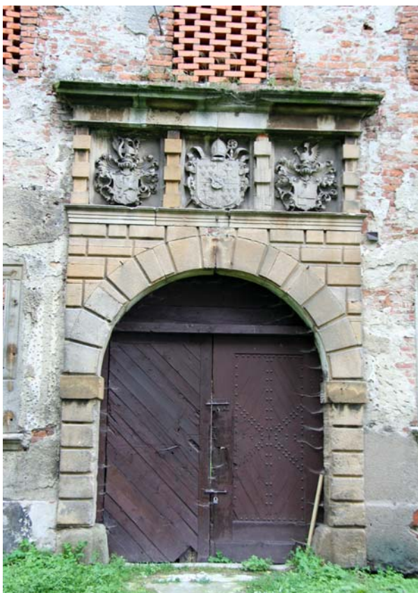
Ryc. 2. Sistrzechowice, pałac, elewacja północna, portal wejścia głównego (fot. A. Legendziewicz)
