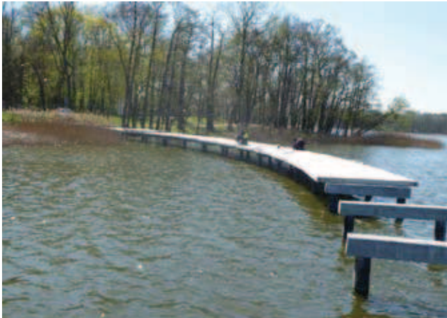
Rys. 2. Zdemontowane płyty pomostowe na fragmencie pomostu zamkowego nad jeziorem Kórnickim
