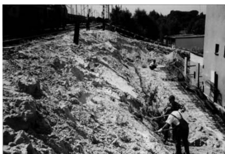
a) rok 1999 realizacja konstrukcji dla uratowania budynku nastawni
