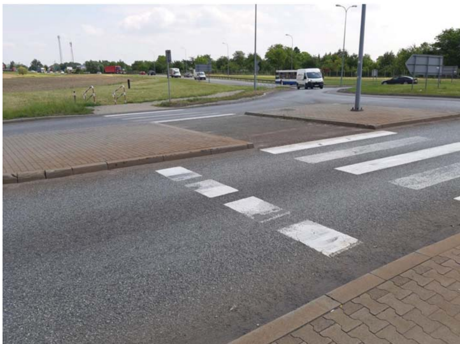
Rys. 5. Widok na wlot autostrady A1 (opracowanie własne)
