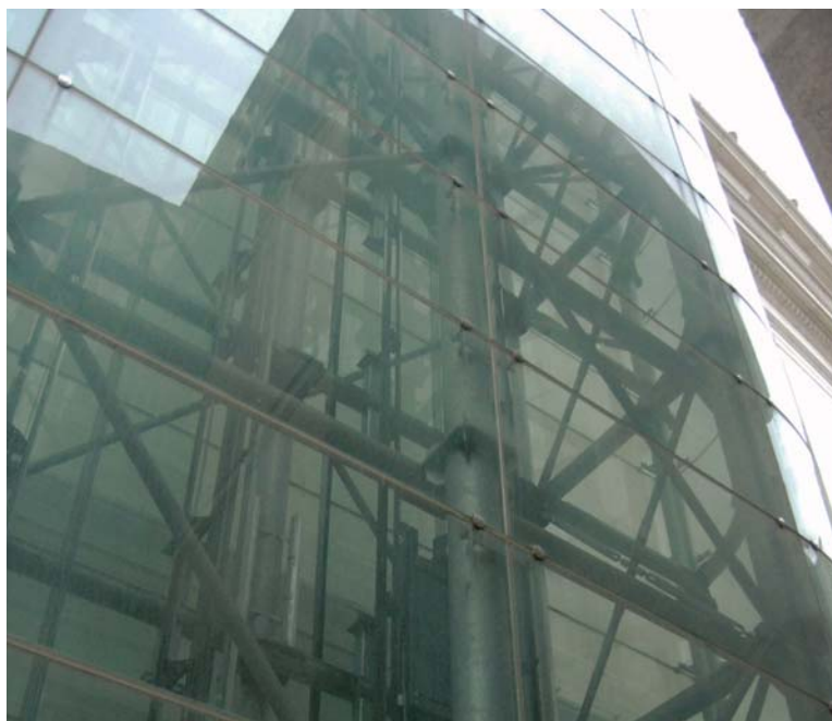
Ryc. 4. Detal oszkleń i konstrukcji pionu windy, Complesso del Vittoriano, Rzym – fot. Ł. Wesółowski
