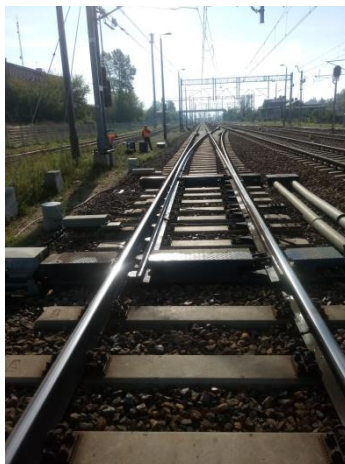
Rys. 2. Rozjazd nr 1 na stacji Siedlce Rzp 1:12-500-60 E1 z PPP
