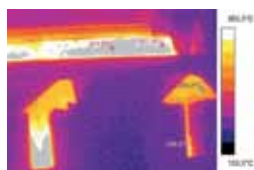
Rys. 17. Rozkłady temperatury na zewnętrznej powierzchni basenu topliwego pieca, ściana boczna, obszar bloków w obszarze początkowym basenu na poziomie lustra szkła oraz powyżej, na łączeniu basenu ze ścianą w przestrzeni ogniowej pieca
