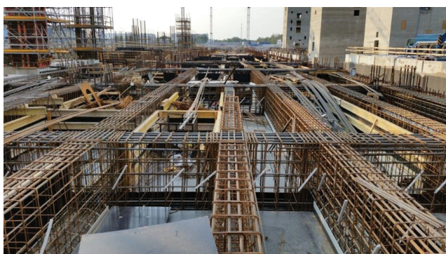
Fot. 4. Przygotowywanie deskowania i zbrojenia elementu o skomplikowanym kształcie
