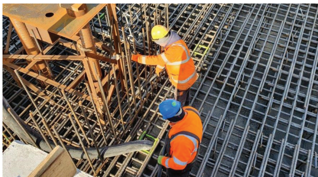
Fot. 6. Rozkładanie mieszanki i jej wibrowanie w miejscu dużego zagęszczenia zbrojenia
