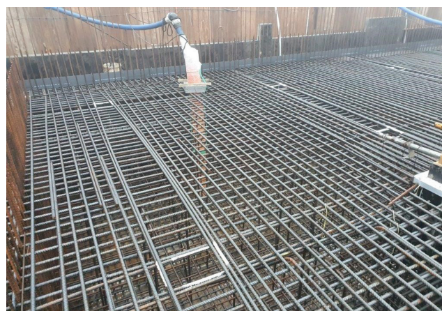
Fot. 1. Przygotowane i oznaczone otwory w zbrojeniu do wprowadzania węża pompy
