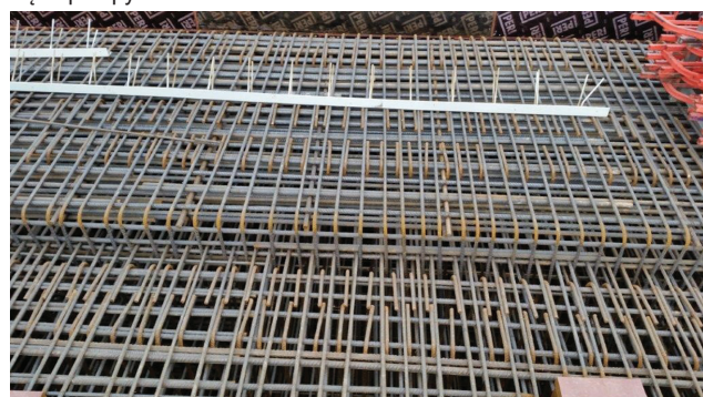
Fot. 3. Zbrojenie przed przygotowaniem otworów do wprowadzania węża pompy
