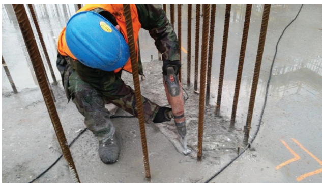
Fot. 7. Uszorstnianie powierzchni styku następnego etapu betonowania
