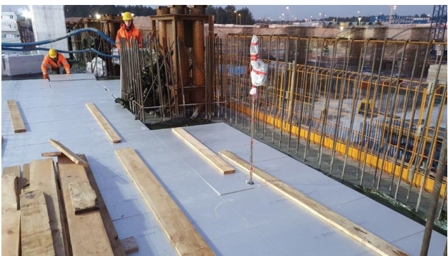
Fot. 12. Pielęgnacja termiczna zabetonowanego bloku fundamentowego
