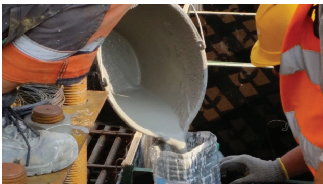
Fot. 8. Zalewanie zaczynem szcpepnym powierzchni styku starego betonu z nowym
