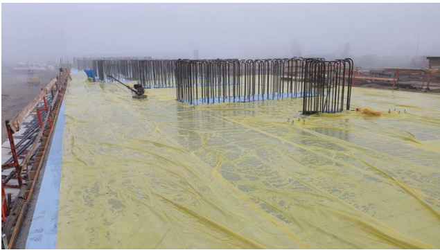
Fot. 11. Pielęgnacja wilgotnościowa powierzchni betonu
