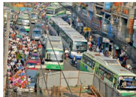
Ryc. 5. Realizacja robót w otwartych wykopach
