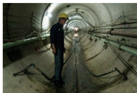
Ryc. 7. Pompowanie bentonitu przez ściankę rury
