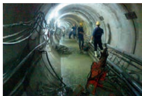
Ryc. 8. Wnętrze kanału w trakcie budowy
