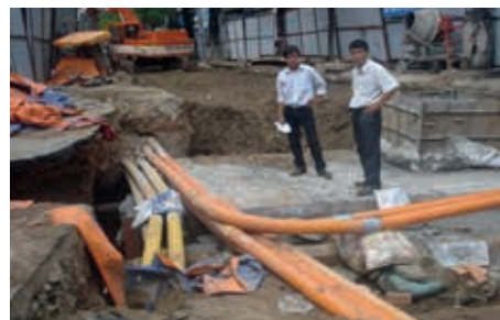
Ryc. 6. Wnętrze wykopu – różne rury istniejące w wykopie na różnych poziomach
