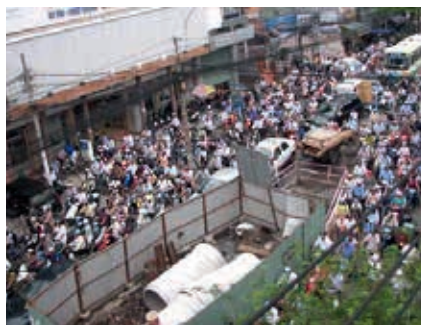
Ryc. 4. Realizacja robót w otwartych wykopach i korki na kilku głównych ulicach przy wymianie i budowie przewodów kanalizacyjnych
