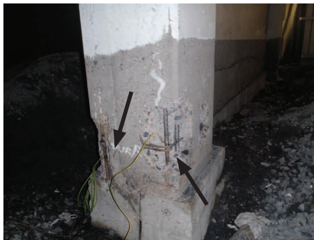
Rys. 2. Połączenie zbrojenia z instalacją
