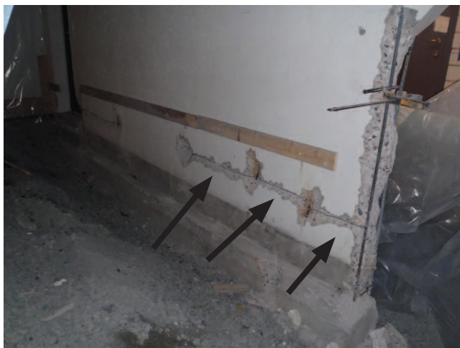
Rys. 1. Poprawienie kontaktu elektrycznego w zbrojeniu
