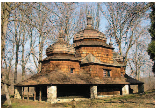
Piątkowa – dawna cerkiew greckokatolicka po pracach zabezpieczających
