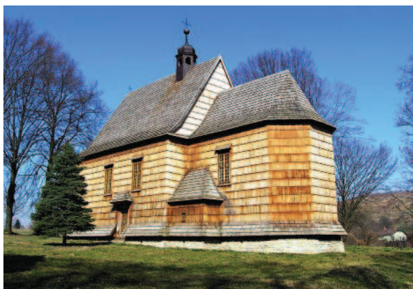
Bachórzec – widok kościoła po pracach konserwatorskich
