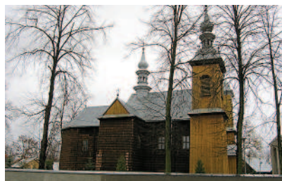
Jaćmierz – widok kościoła po pracach konserwatorskich
