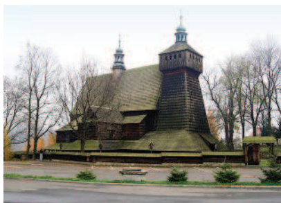
Haczów – widok ogólny kościoła (stan przed wymianą poszycia gontowego)
