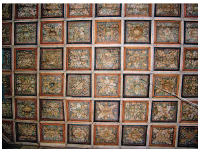
Trzcinica – strop prezbiterium po pracach konserwatorskich
