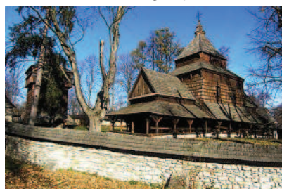
Radruż – widok zespołu cerkiewnego po pracach konserwatorskich
