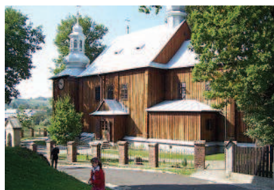
Jasienica Rosielna – widok kościoła po pracach konserwatorskich
