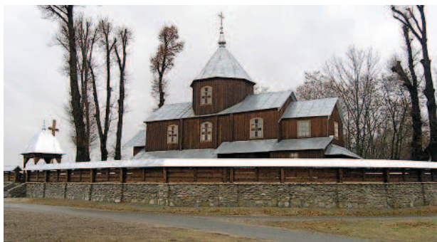
Młyny – widok ogólny zespołu cerkiewnego po pracach konserwatorskich
