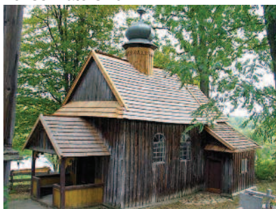
Koniusza – widok cerkwi po pracach konserwatorskich dachów
