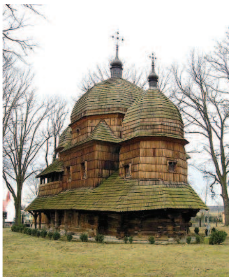
Chotyniec – widok cerkwi po pracach konserwatorskich
