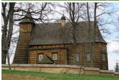
Trzcinica – widok kościoła po pracach konserwatorskich
