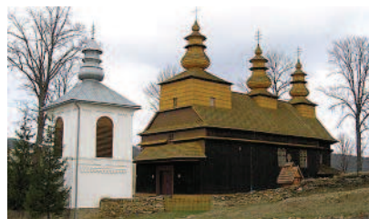
Wisłok Wielki – widok zespołu cerkiewnego po kompleksowych pracach konserwatorskich
