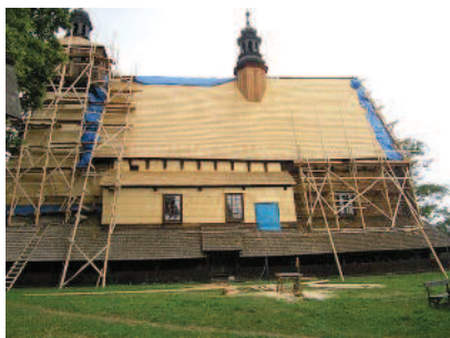
Haczów – kościół w trakcie prac konserwatorskich
