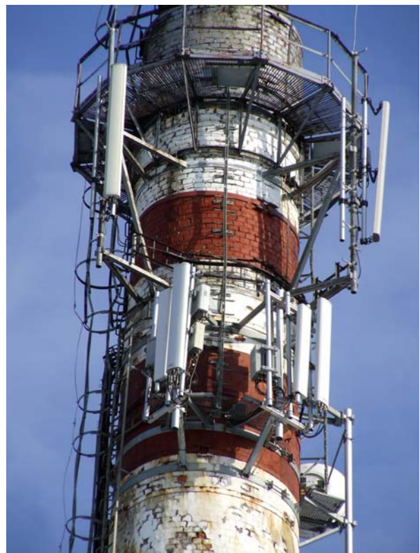
Ryc. 11. Widok ogólny galerii stalowej Fig. 11. General view of the steel gallery
