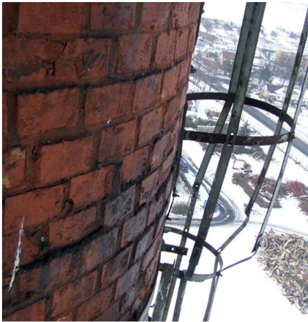
Ryc. 6. Stan powierzchni płaszczu w górnej partii komina Fig. 6. The jacket surface condition in the upper part of the chimney
