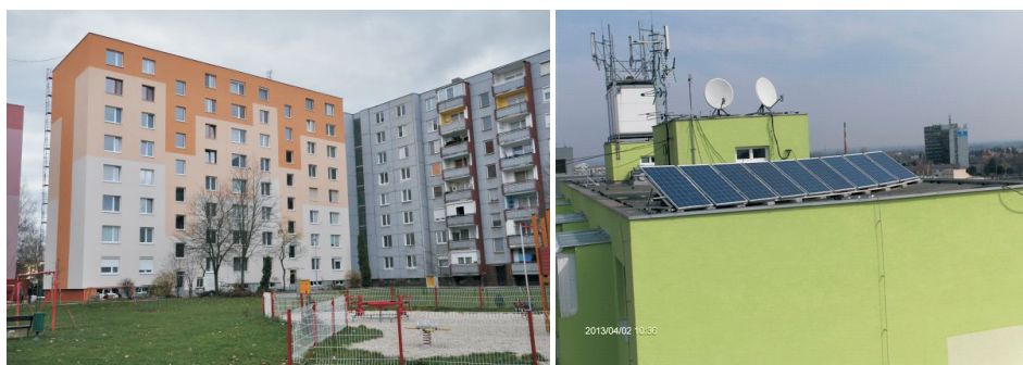
Fot. 5. Termomodernizacja budynków mieszkalnych w Galancie (źródło: www.geothermalcommunities.eu )
