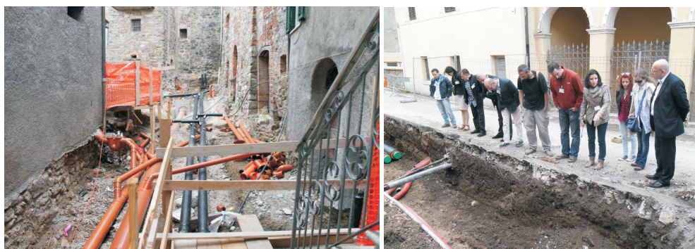
Fot. 6. Nowy rurociąg sieci c.o. w Montieri (źródło zdjęć: www.geothermalcommunities.eu )
