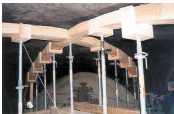
Fot. 14. Sposób podparcia sklepienia
