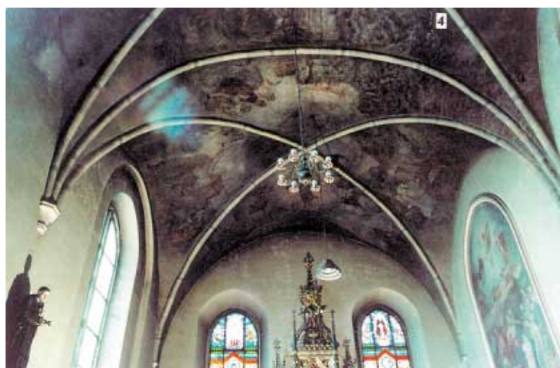
Fot. 12. Ogólny widok sklepienia
