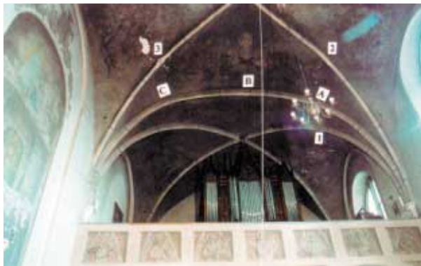
Fot. 2. Widok sklepienia od strony chóru
