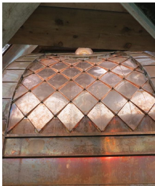
Ryc. 10. Fragment detalu pracy blacharskiej (fot. H. Mełges)
