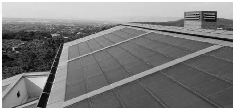
Rys. 1. Przykład zastosowania bitumicznej dachówki fotowoltaicznej [7]
