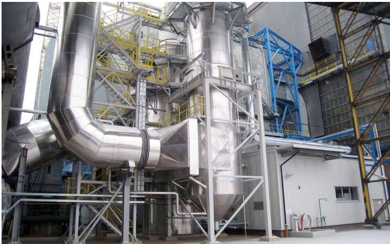
Rys. 6. Układ odzysku ciepła ze spalin kotła biomasowego
