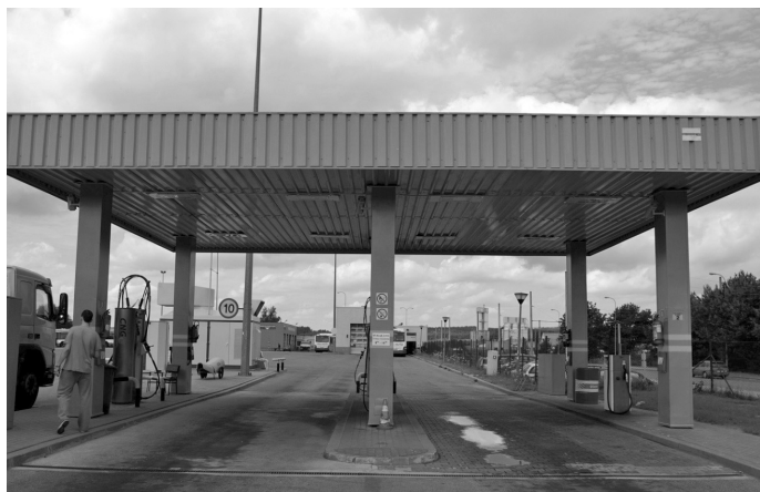
Fot. 7. Stacja tankowania CNG (na prawym pasie ruchu dystrybutory przystosowane do komercyjnego tankowania samochodów osobowych) i ON na terenie zajezdni PKM Gdynia
