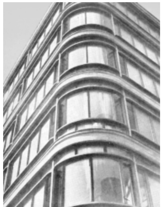
8. Centralny Dom Towarowy w Warszawie przy Al. Jerozolimskich 1948-1952, Ihnatowicz, Romański, detal elewacji
