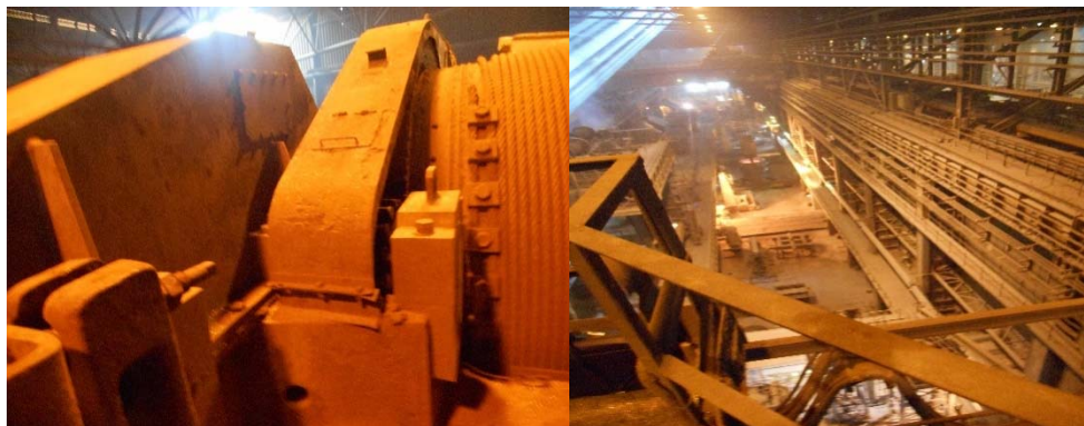
Rysunek 2. Fragment obudowy układu napędowego suwnicy oraz widok hali produkcyjnej z poziomu pomostu operatorskiego.
