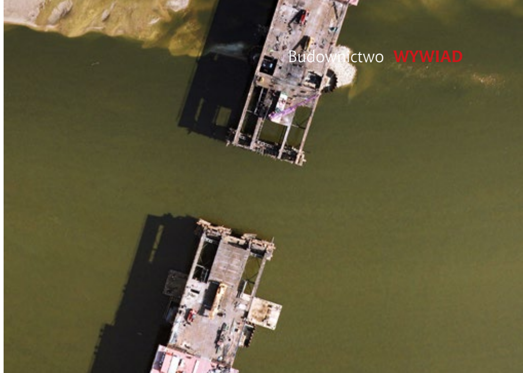
Odbudowa mostu Łazienkowskiego w Warszawie
