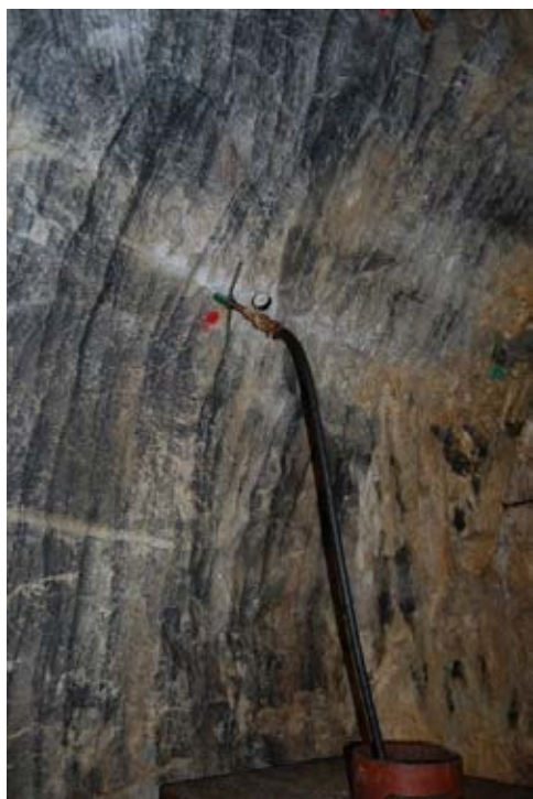
Ryc. 5. Aktualne ujęcie wycieku.
