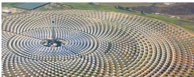
Rys. 1. Helioelektrownia typu wieżowego, pole heliostatów otacza wieżę słoneczną ze wszystkich stron, źródło: EcoGuard
