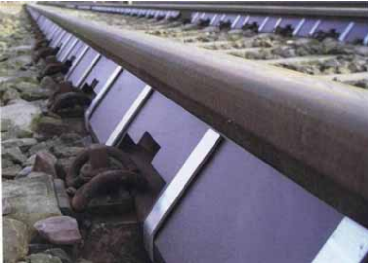
Fot. 2. Ekranowanie szyn
