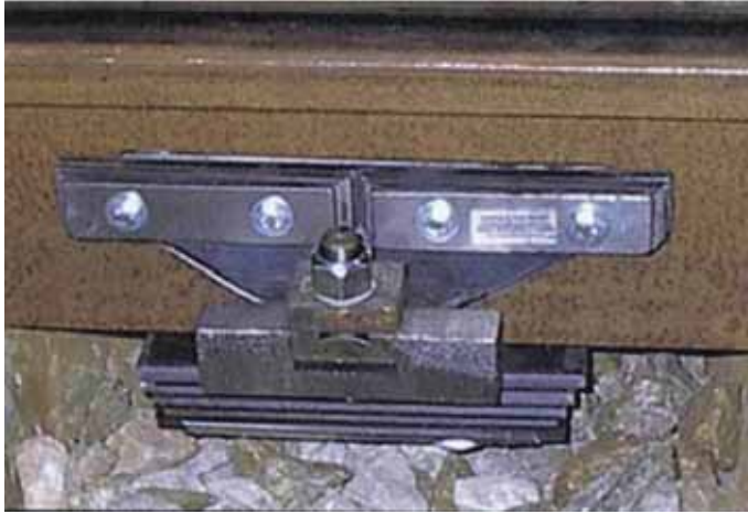
Fot. 3. Element tłumiący drgania umieszczany pod szyną na moście
