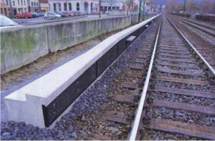
Fot. 1. Niskie ekrany akustyczne wykonane z elementów betonowych lub gabionów
