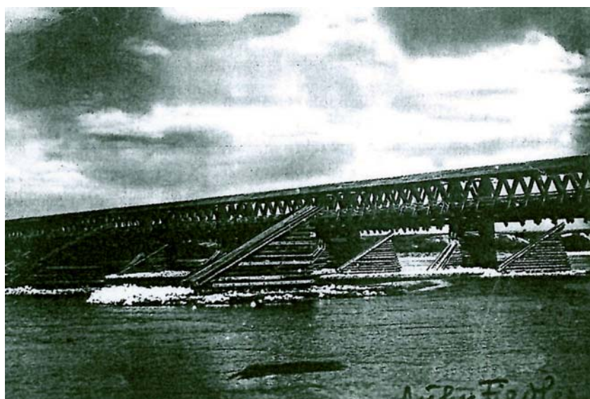
Fot. 4. Kratownicowy most drewniany przez rzekę Wisłę w Annopolu, 1917 rok [2]
