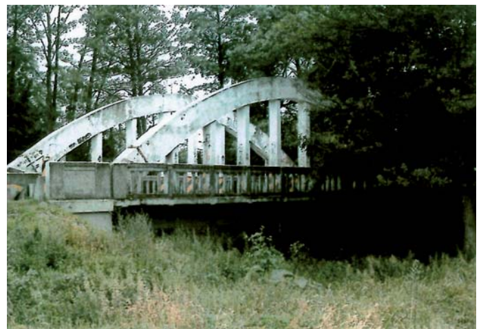
Fot. 1. Most przez rzekę Biała Łada w Biłgoraju w ciągu ul. Lubelskiej: a) widok w czasie budowy [1], b) widok obecnego mostu
