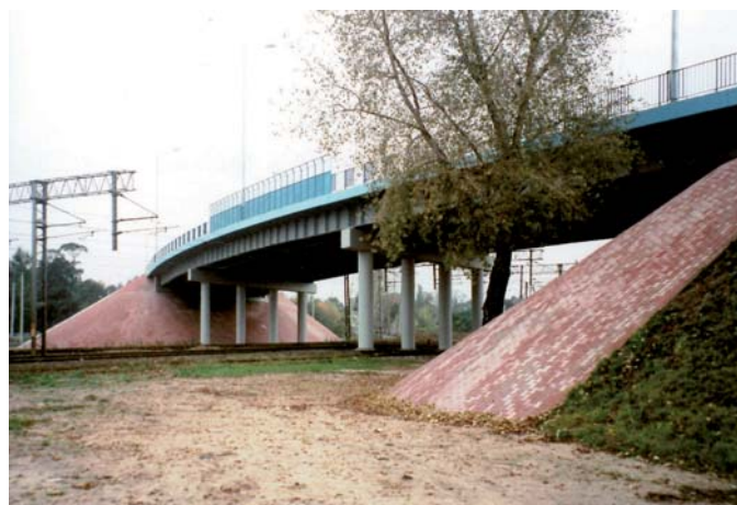
Fot. 18. Wiadukt nad linią kolejową Warszawa – Lublin w Dęblinie
