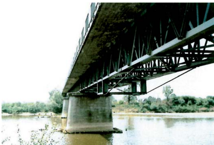
Fot. 15. Most na rzece San w Ulanowie po wzmocnieniu ustroju nośnego
