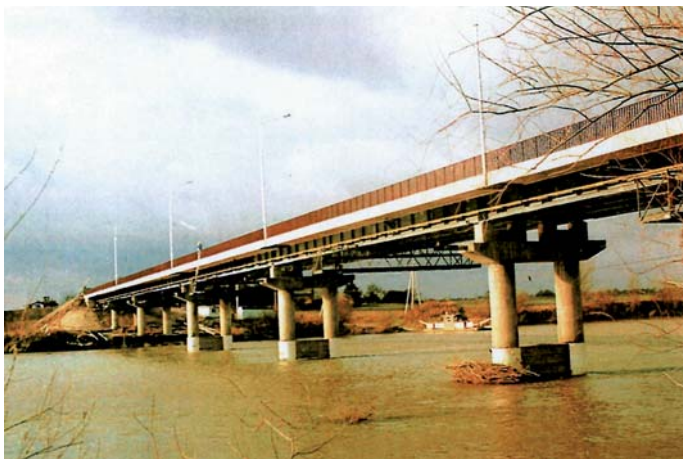
Fot. 16. Most na rzece San w Krzeszowie po przebudowie
