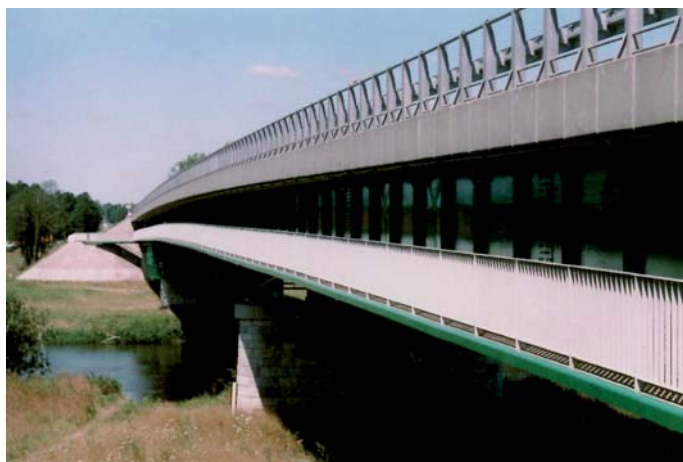
Fot. 19. Most przez rzekę Wieprz w Kośminie po przebudowie
