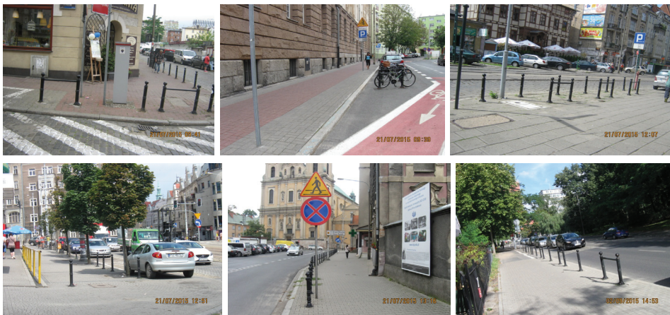
Rys. 4. Elementy małej architektury ograniczające postój pojazdów niezgodny z przepisami
