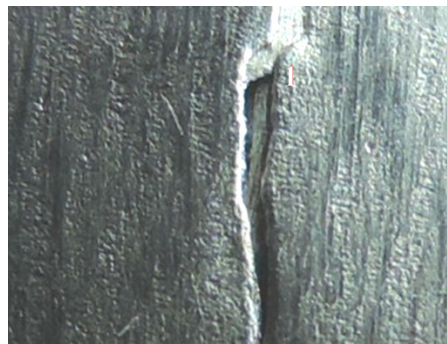
Rys. 15. Miejsce obserwacji pęknięcia (dostawca pierwszy)
