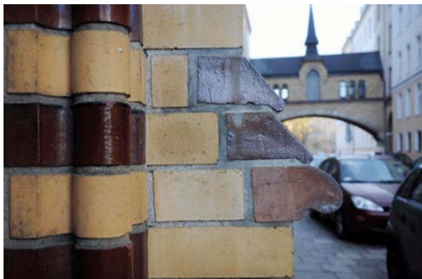
Ryc. 4. Detal elewacji z kształtkami szklwionymi budynku Zakładu Opiekuńczego przy ul. św. Józefa we Wrocławiu [17] Fig. 4. Glazed pattern detail of the façade of the Health Care Centre on St. Joseph Street in Wrocław [17]
