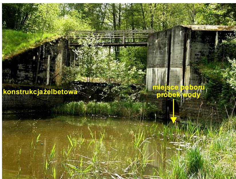
Fot. 1. Jaz nr 712, z oznaczeniem miejsca poboru próbek wody Fot. 1. Water weir No. 712, with indication of the water sampling place
