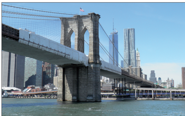
Fot. 1. Widok na pylon i przęsło skrajne mostu Brooklyńskiego od strony Manhattanu. Pomost mostu jest obecnie w remoncie
