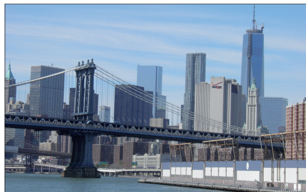
Fot. 2. Widok na przęsło skrajne i stalowy pylon mostu Manhattańskiego na tle Manhattanu
