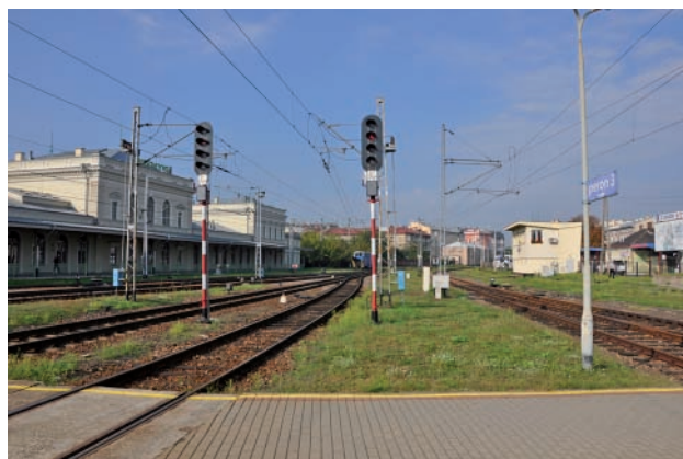
Rys. 2. Stacja Przemyśl Gł., stacja graniczna z siecią UZ: po lewej stronie znajduje się zelektryfikowane napięciem 3 kV DC: LK 91 (1435 mm), po prawej – LK 92 (1520 mm) (16.09.2016 r.) [fot. M. Graff]
