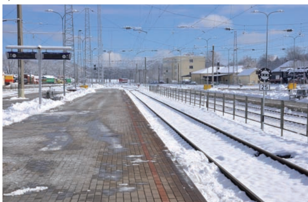
Rys. 9. Przewody jezdne sieci trakcyjnej i różnice między systemem 3 kV oraz 25 kV): a) stacja LG Wilno (1520 mm, 25 kV 50 Hz (20.03.2016 r.), b) RŽD Swietlogorsk-2 (niem. Rauschen-Düne, pol. Ruszowice), O. Królewiecki (1520 mm, 3 kV DC) (2.05.2016 r.) [fot. M. Graff]
