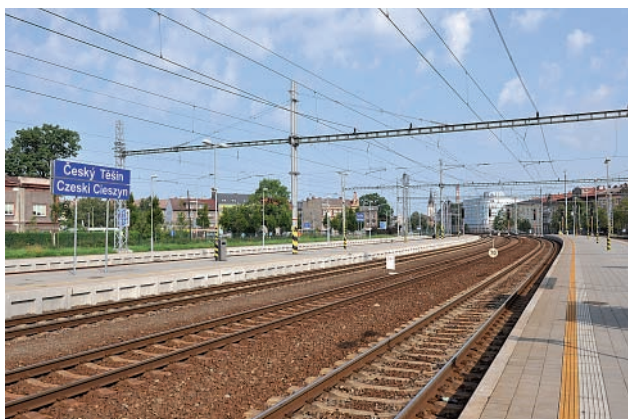
Rys. 7. Stacja Pribeník na linii Koszyce – Čierna na Tisou (3 kV DC), Słowacja (4.09.2022 r.) [fot. M. Graff]
