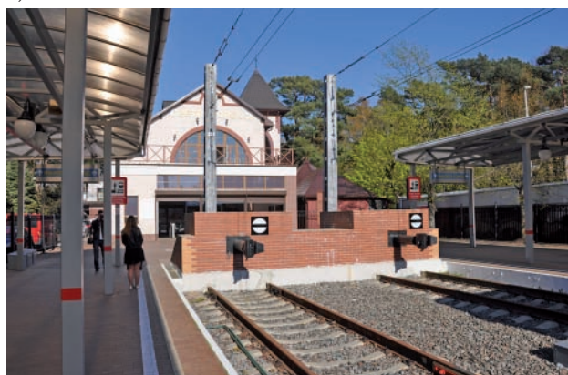
Rys. 9. Przewody jezdne sieci trakcyjnej i różnice między systemem 3 kV oraz 25 kV): a) stacja LG Wilno (1520 mm, 25 kV 50 Hz (20.03.2016 r.), b) RŽD Swietlogorsk-2 (niem. Rauschen-Düne, pol. Ruszowice), O. Królewiecki (1520 mm, 3 kV DC) (2.05.2016 r.) [fot. M. Graff]
