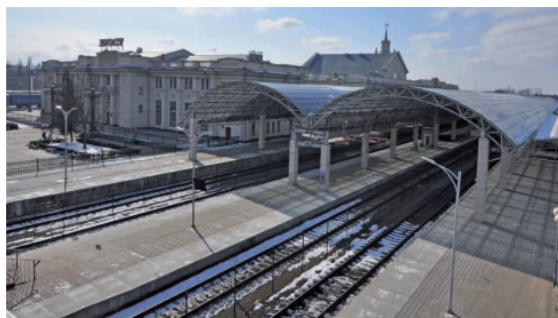
Rys. 4. Stacja Brześć Centr. na granicy polsko-białoruskiej i tzw. część warszawska dworca: dwa tory od lewej o rozstawie 1435 mm i zelektryfikowane napięciem 3 kV DC, a dwa kolejne (od prawej strony) – tory szerokie (1520 mm) zelektryfikowane napięciem 25 kV 50 Hz (25.02.2018 r.) [fot. M. Graff]
