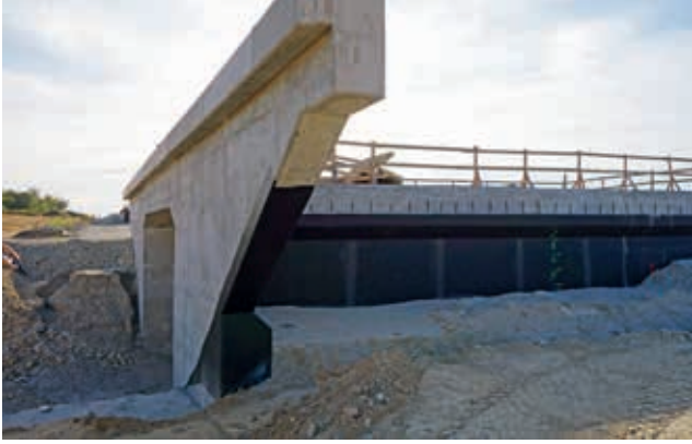
Ryc. 7. Widok bitumicznej izolacji powłokowej na pionowej i poziomej powierzchni konstrukcji głowicy i skrzydełka przepustu, fot. A. Wysokowski
