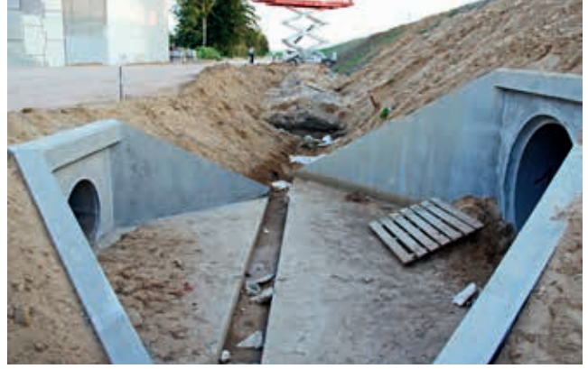
Ryc. 13. Przykład nowoczesnego rozwiązania umocnienia wlotu przepustu podczas realizacji, polegający na wykonaniu dolnej płyty żelbetowej połączonej z konstrukcją skrzydełek, fot. A. Wysokowski
