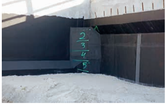
Ryc. 9. Widok zasypki konstrukcyjnej przepustu skrzynkowego w trakcie jej wykonywania. Widoczne technologiczne zaznaczenie miąższości poszczególnych warstw na wewnętrznym elemencie skrzydełka, fot. A. Wysokowski
