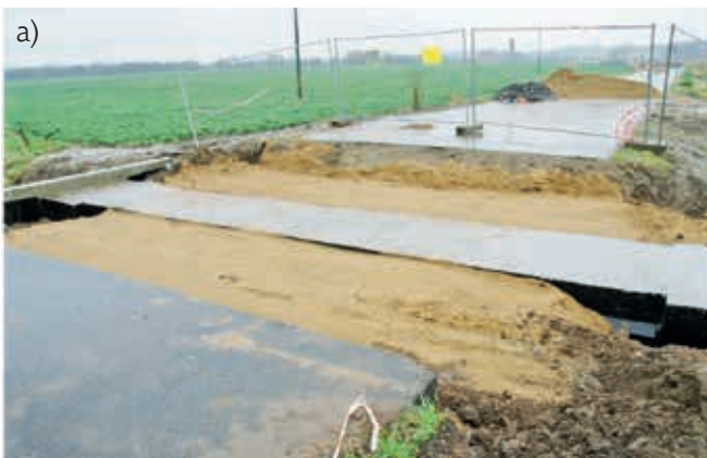
Ryc. 14. Przykład wykonywania nawierzchni nad konstrukcją przepustu skrzynkowego: a) widok etapu wykonywania warstw podbudowy pod nawierzchnię, b) widok wykonanej warstwy wiążącej na obiekcie, fot. A. Wysokowski
