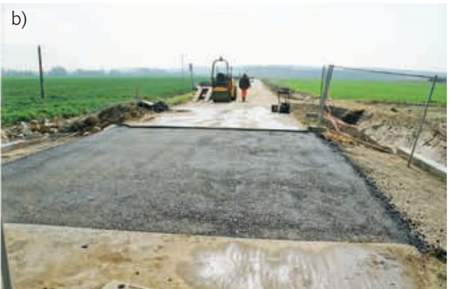
Ryc. 14. Przykład wykonywania nawierzchni nad konstrukcją przepustu skrzynkowego: a) widok etapu wykonywania warstw podbudowy pod nawierzchnię, b) widok wykonanej warstwy wiążącej na obiekcie, fot. A. Wysokowski
