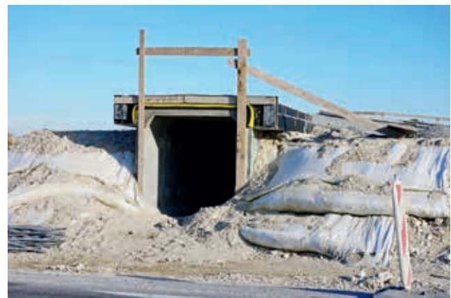
Ryc. 11. Widok wykorzystania geotekstyliów w konstruowaniu zasypki obiektu posadowionego w trudnych warunkach gruntowo-wodnych, fot. A. Wysokowski
