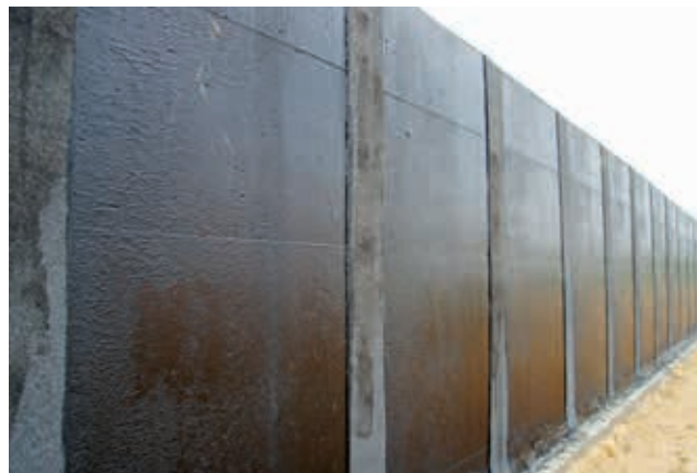
Ryc. 6. Widok bitumicznej izolacji powłokowej na pionowej powierzchni prefabrykatów żelbetonowych. Widoczne dodatkowe uszczelnienie w obrębie styków segmentów prefabrykowanych za pomocą izolacji arkuszowej – papy termozgrzewalnej, fot. A. Wysokowski
