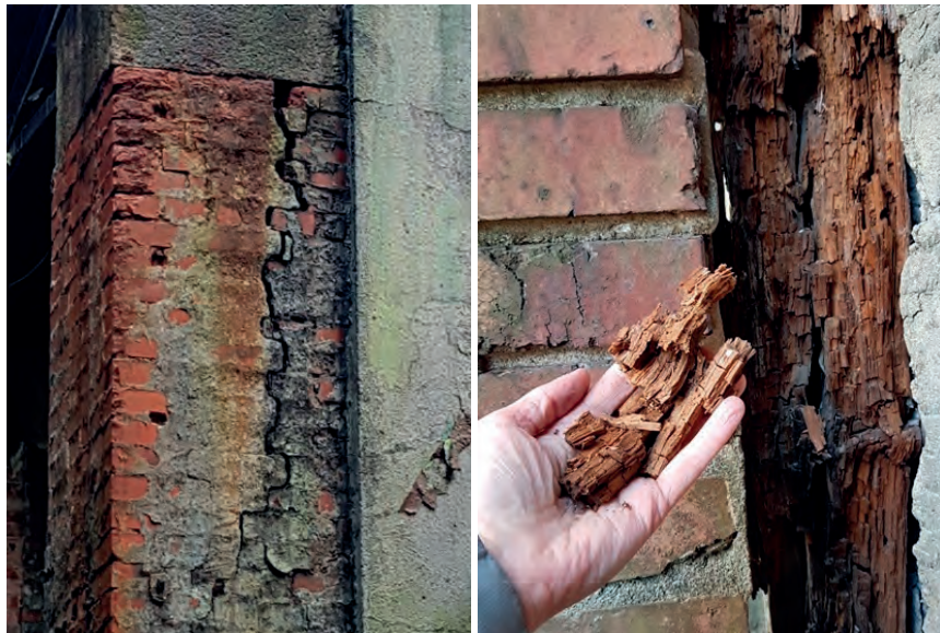
Rys. 1. Przykłady niespełnienia wymagań dotyczących niezawodności konstrukcji ze względu na: a) nośność (fot. Materiały informacyjne Państwowej Inspekcji Pracy), b) użytkowalność, c) trwałość
