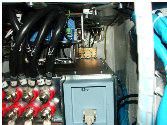
Rys. 2. fragment wyposażonej osłony ognioszczelnej
