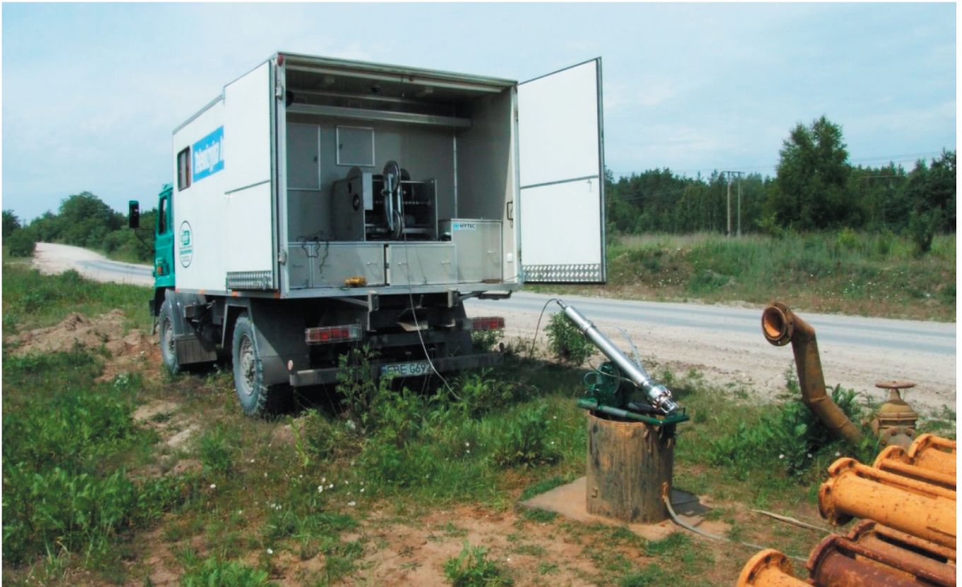
Fot. 1. Wykonywanie wizyjnej inspekcji studni głębinowej Fot. 1. Execution of television inspection well
