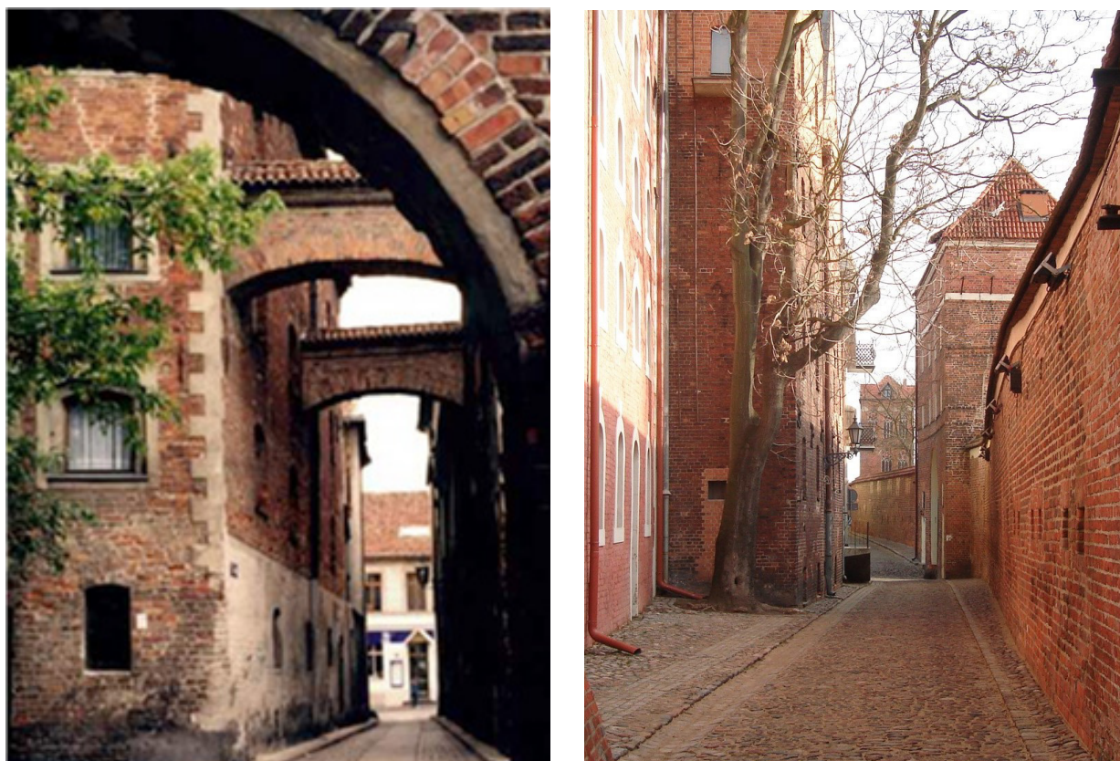
Ryc. 6. Krajobraz miejski zamknięty: A – wewnątrz ulicy z łukami rozporowymi zamknięte kamienicą (Toruń, ul. Ciasna); B – ulica z basztą obronną zamknięta perspektywicznie (Toruń, ul. Bankowa)
