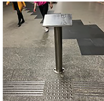
Fot. 4. Mapa tyflograficzna peronu stacji metra Politechnika i ścieżki orientacji; źródło: fot. Anna Tofiluk
