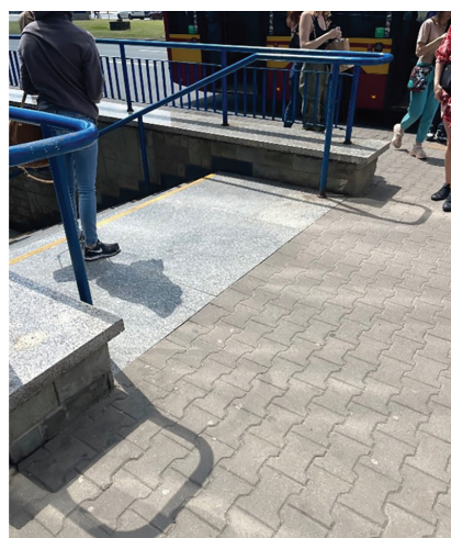
Fot. 3. Przykłady braku udogodnień dla osób niewidomych na stacji Politechnika; źródło: fot. Anna Tofiluk
