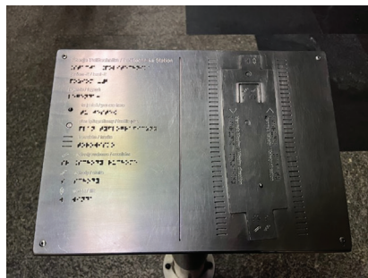
Fot. 4. Mapa tyflograficzna peronu stacji metra Politechnika i ścieżki orientacji; źródło: fot. Anna Tofiluk
