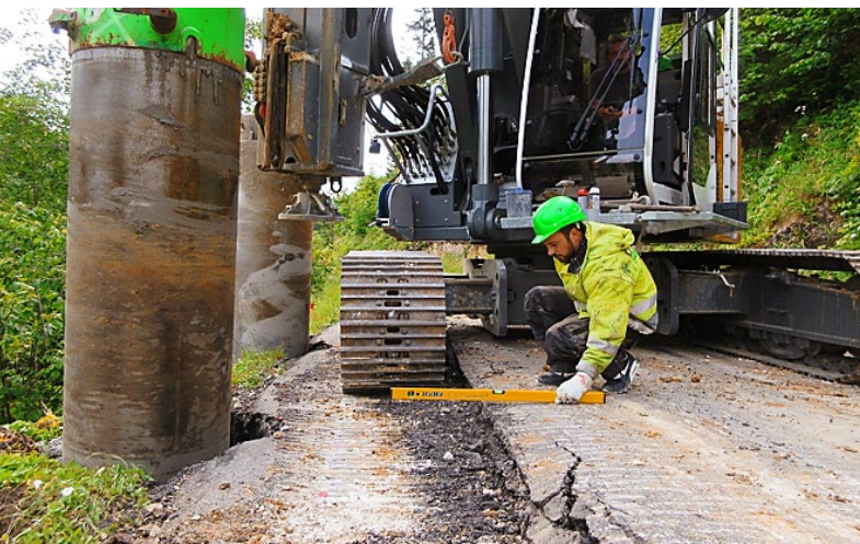
Ryc. 2. Porównanie warunków sprzętowych przy stabilizacji osuwiska po zmianie palisady z pali D = 60 cm na barierę z mikropali TITAN 52/26 przy drodze K 7406 Asch – Bermaringen
