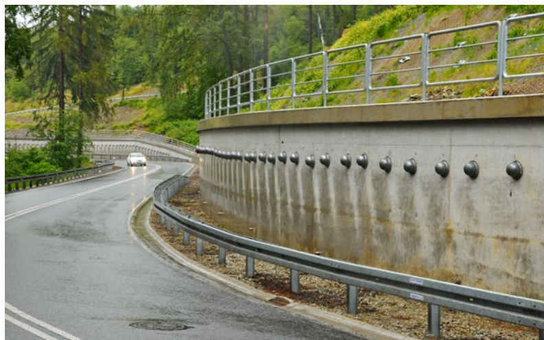
Ryc. 4. Zespół konstrukcji stabilizujących: palisada kotwiona tworząca ścianę oporową, skarpa gwoździowana, poniżej bariera mikropalowa, DW941 Wisła – Istebna
