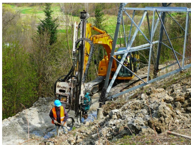
Ryc. 5. Wzmocnienie posadowienia słupa energetycznego na aktywnym osuwisku przez przestrzenny układ mikropali, Krościenko nad Dunajcem
