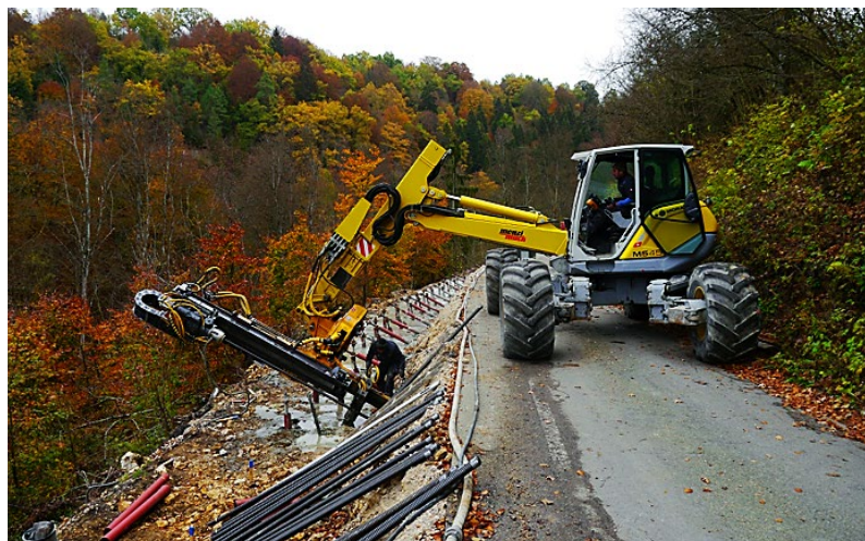
Ryc. 2. Porównanie warunków sprzętowych przy stabilizacji osuwiska po zmianie palisady z pali D = 60 cm na barierę z mikropali TITAN 52/26 przy drodze K 7406 Asch – Bermaringen
