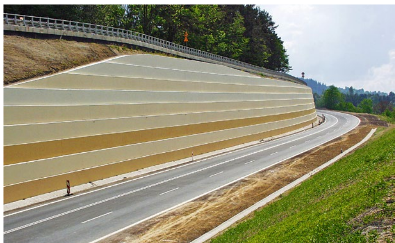
Ryc. 3. Zabezpieczanie skarp osuwiskowych konstrukcją gwoździowaną – możliwość kształtowania wykończenia: oblicowanie na zielono (Skarpa Zamkowa, Sandomierz) i żelbetowe monolityczne (droga ekspresowa S69 Zwardoń)
