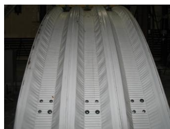
b) wygląd profilu po montażu
