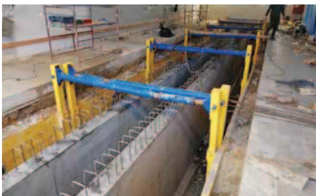
Rys. 6. Fragment przedstawiający realizację kanału serwisowego z wykorzystaniem zaprojektowanej obudowy liniowej firmy KOPRAS
