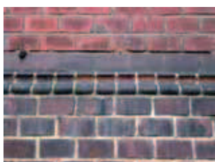
Rys. 6. Cokół budynku – widoczne kształtki (źródło: archiwum autora)
