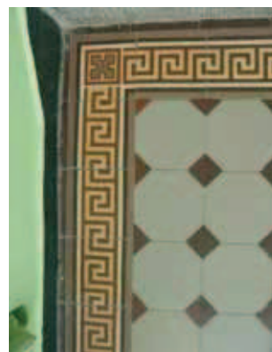
Rys. 13. Fragment posadzki na podestach klatki schodowej (źródło: archiwum autora)
