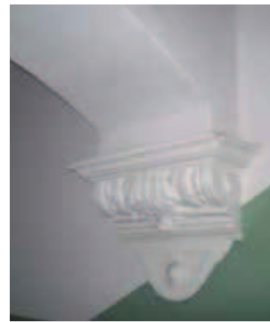
Rys. 22. Detal klatki schodowej III piętra (źródło: archiwum autora)
