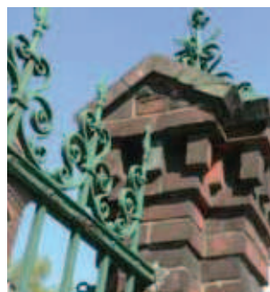
Rys. 23. Słupek ogrodzenia (źródło: archiwum autora)
