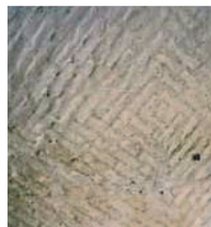
Rys. 15. Sklepienie ceglane w pracowni sztukatorskiej (źródło: archiwum autora)
