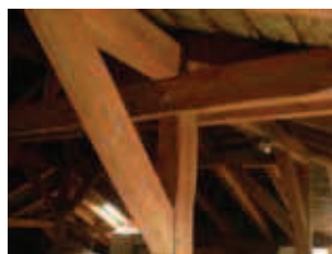
Rys. 16. Więzar płatwiowokleszczowy więźby dachowej (źródło: archiwum autora)
