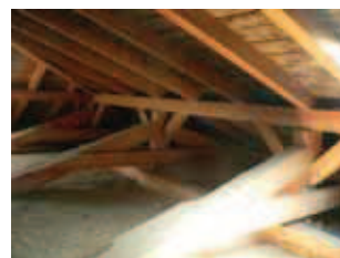
Rys. 17. Konstrukcja dachowa w części bocznej budynku, nad salami lekcyjnymi (źródło: archiwum autora)
