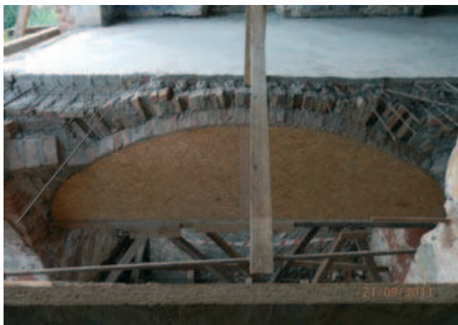
Rys. 8. Odtwarzanie sklepienia zespolonego z wierzchnią płytą żelbetową
