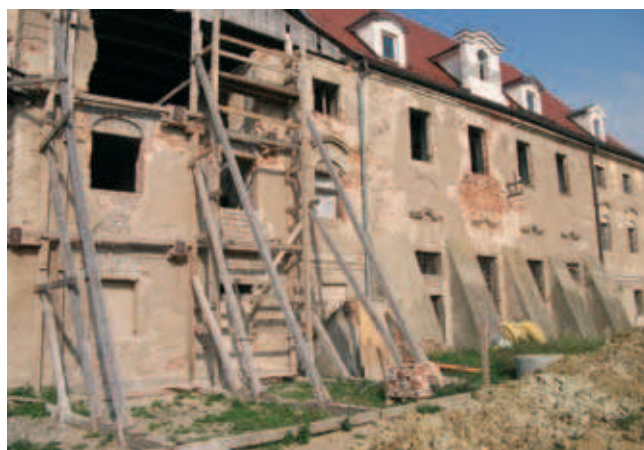
Rys. 2. Widok ściany południowej skrzydła zachodniego oraz frontu skrzydła południowego
