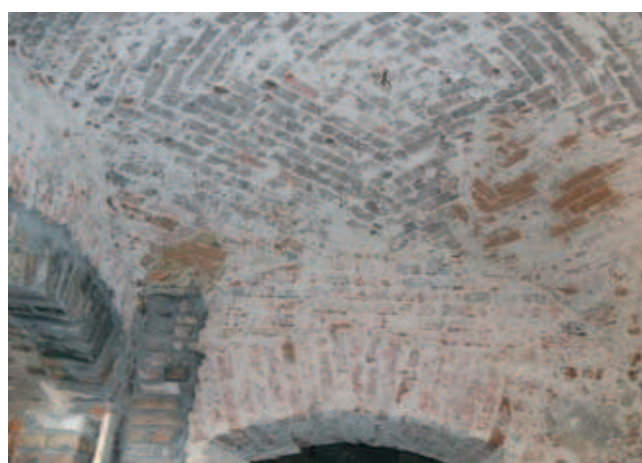
Rys. 7. Uzupelnione ubytki konstrukcji łęku i sklepienia
