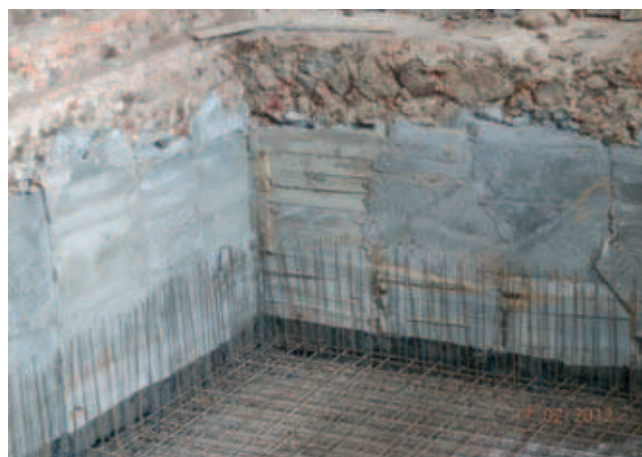
Rys. 6. Podbicie ścian fundamentowych z przygotowanym zbrojeniem płyty dennej i pionowym, startowym ścian skrzywni żelbetowej
