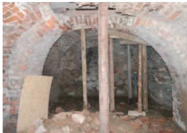
Rys. 4. Otwory w sklepieniach kondygnacji piwnicznej w skrzydle zachodnim
