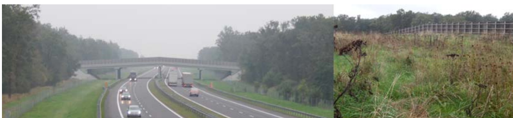
Ryc. 1. Przejścia: nr 1, nr 2, nr 3. Od lewej strony: widok na przejście dla zwierząt od strony użytkowników drogi, widok na przejście dla zwierząt od strony migrującej zwierzyny. Źródło: fot. M. Mojecka
