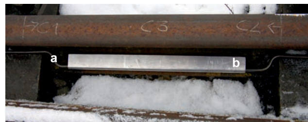
Rys. 5. Prototypowe grzejniki bezstykowe firmy TERMORAD: a) grzejnik bezstykowy, b) radiator [fot. D. Brodowski]
