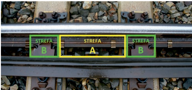
Rys. 1. Strefy wytapiania śniegu w obszarze roboczym ogrzewania opornic [fot. D. Brodowski]
